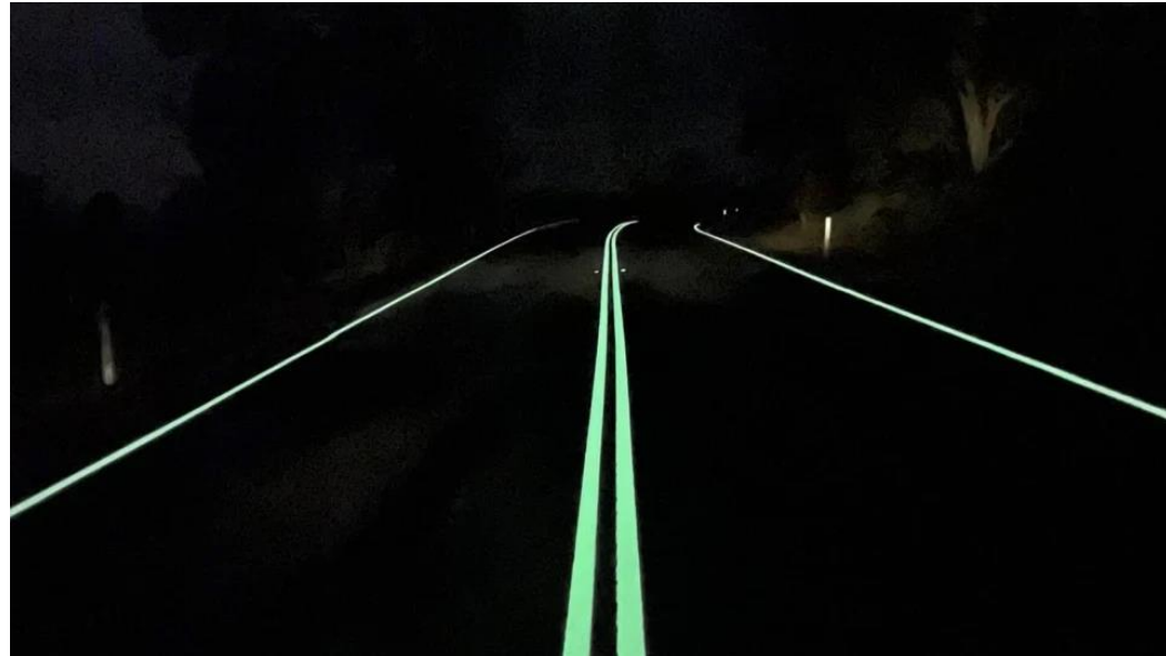
Figura 9 Segnaletica orizzontale fotoluminescente. Fonte: www.engineeringexploration.com .
