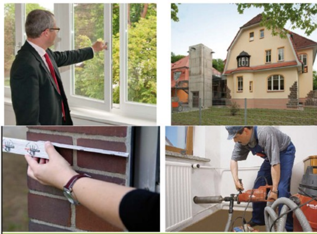
Figura 4.3 – Interventi di mitigazione negli edifici intorno all'aeroporto di Schönefeld
