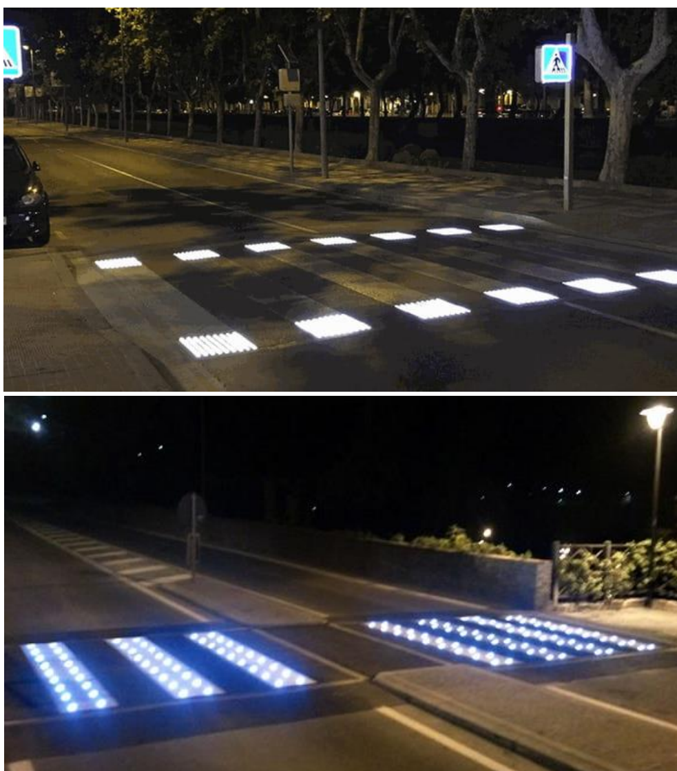
Figura 21 - Esempio di strisce pedonali intelligenti. Fonte: www.lastampa.it/motori/tecnologia ; https://www.lombardiaspeciale.regione.lombardia.it .
