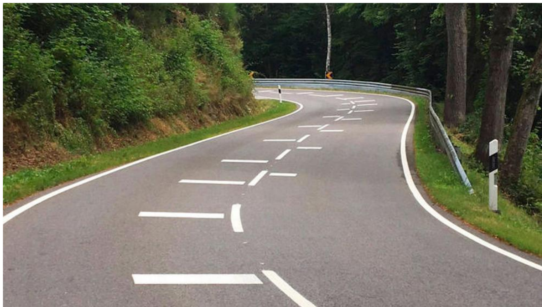
Figura 24 - Esempio di segnaletica orizzontale "salvamotociclisti". Fonte: www.inmoto.it .
