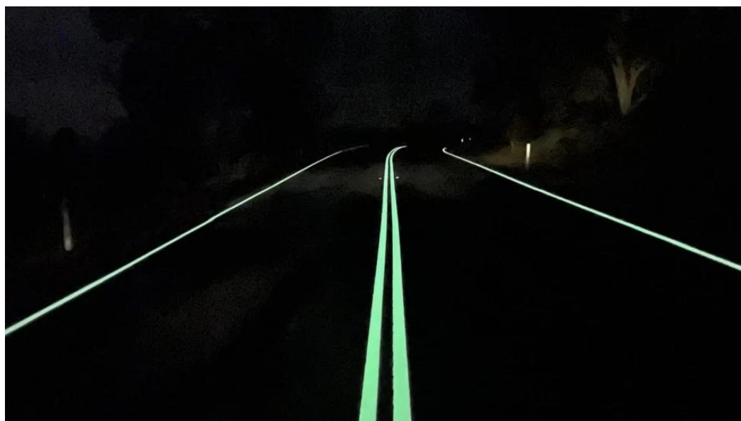
Figura 9 - Segnaletica orizzontale fotoluminescente. Fonte: www.engineeringexploration.com .
