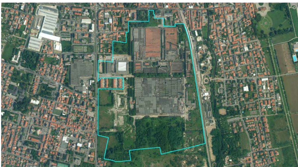
Figura 9.18 - Dismissione totale in Comune di Varedo.
