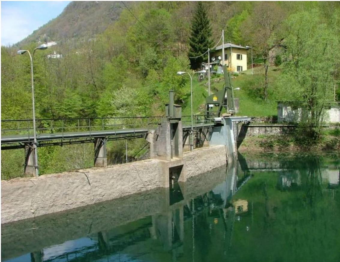
Figura 6 - Vista da monte sulla diga di Pagnona con scarico di fondo, sgrigliatore e casa di guardia (maggio 2006).
